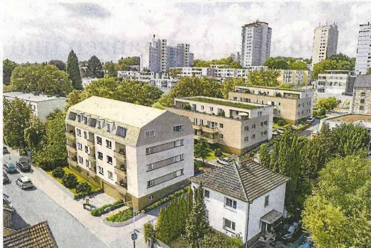
Entlang der Wilhelmshöher Straße entstehen zwölf öffentlich-geförderte Mietwohnungen in einem Haus mit ortstypischem Sattelgeschoss, dahinter 26 freifinanzierte Mietwohnungen in zwei Häusern. Visualisierung: GSW
